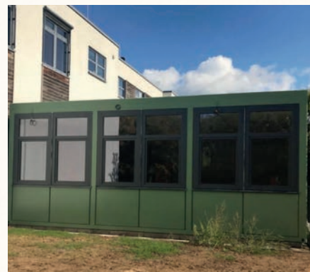
Modular school expansion (Bereldange)
