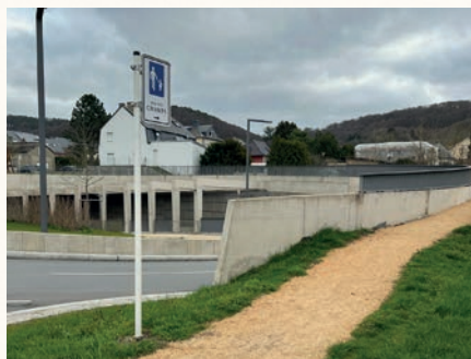
Footpath from Rue de Chemin de Fer to Rue des Champs, along the PN17 underground passage.
