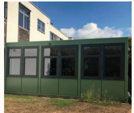
Modular school expansion (Bereldange)
